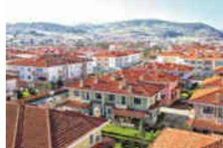
17 Ağustos Depremi'nden Bir Fotoğraf A Photo from 17 August Earthquake
